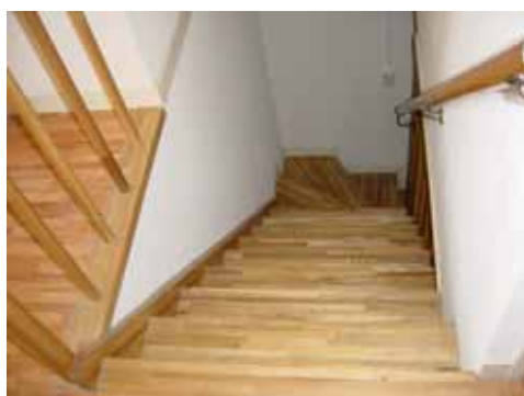
床スラブの一部を抜いて住宅内に階段をつかった 上下メゾネット型の2戸1戸化
