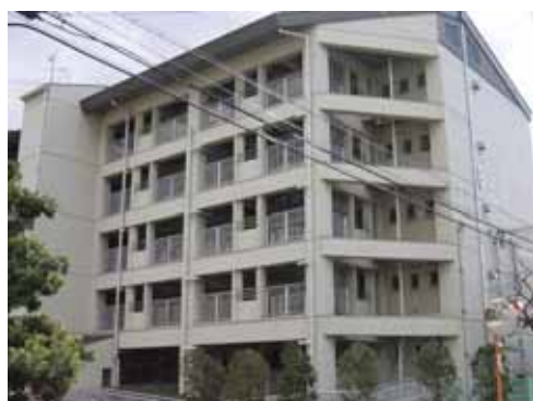
増築部分を北側から見たところ
