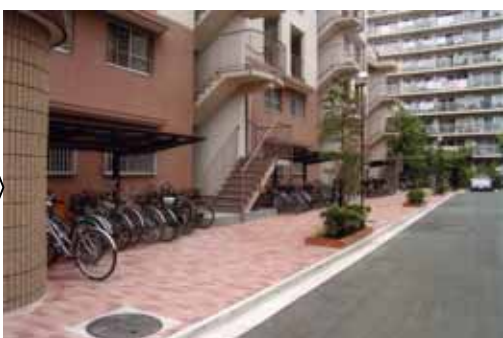
住棟前歩道の舗装のグレードアップ (歩道の拡幅及びインターロッキング舗装)
