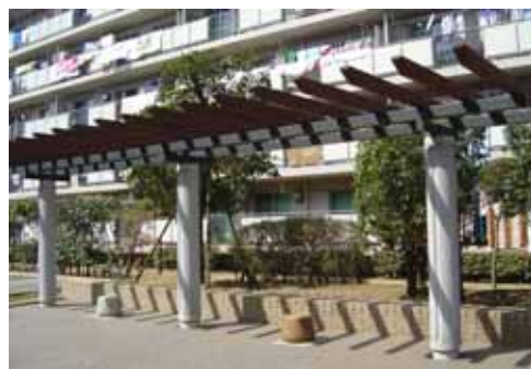
パーゴラ・ベンチの設置
