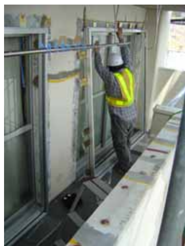
外付け工法によるバルコニーの掃出しサッシの2重化(工事中)
