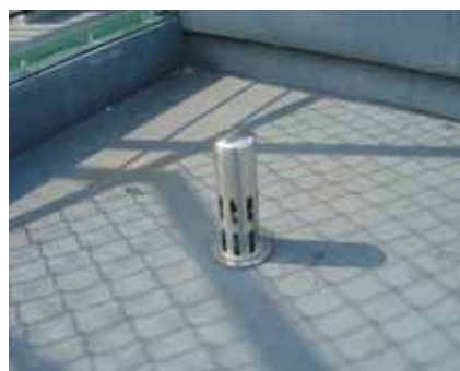
脱気装置(かぶせ方式・絶縁工法)
