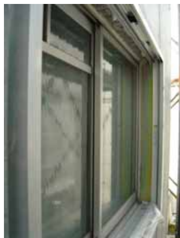
外付け工法による窓サッシの2重化
