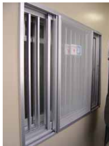
非常時脱出機能付き面格子の設置
