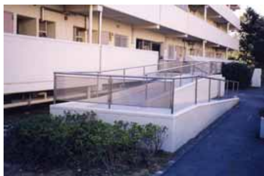
1階共用外廊下へのスロープ設置
