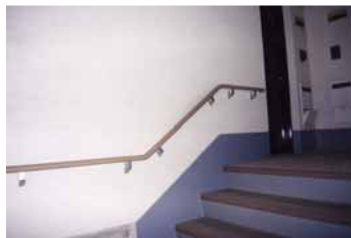
共用階段への手すり設置
