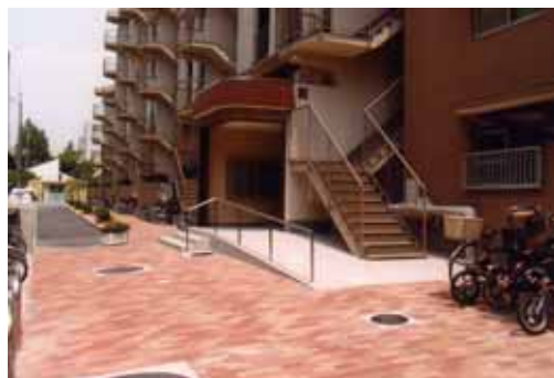
エントランスアプローチ部分の小段差にスロープを設置
