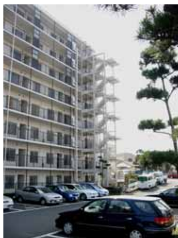
取替え後の屋外鉄骨階段と階段へのスロープ設置
