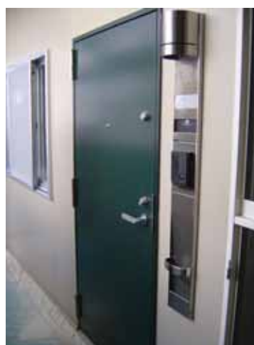
ドアの取替えにあわせた住戸ドア周りのグレードアップ(門灯、室名札、インターホン、新聞受けホルダーが一体となった玄関ドア脇パネルの新設)
