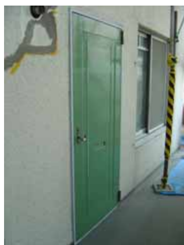
ドアの取替えにあわせた住戸ドア周りのグレードアップ(門灯、室名札、インターホン、新聞受けホルダーが一体となった玄関ドア脇パネルの新設)
