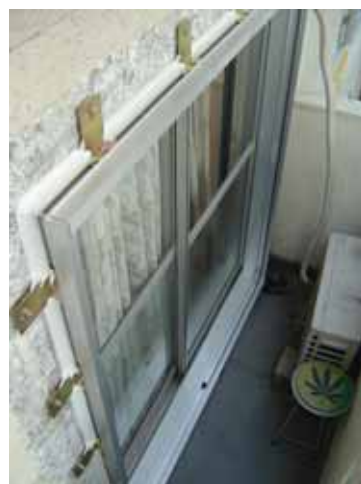
外付け工法によるバルコニーの掃出しサッシの2重化(工事中)
